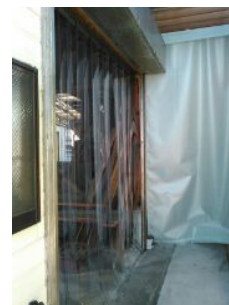
防音工事①
